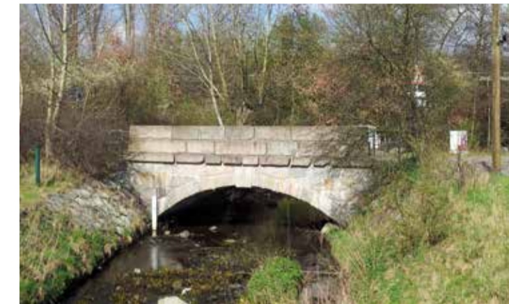
Als steinerner Zeitzeuge spannt sich die Franzosenbrücke über die Gliner Au
