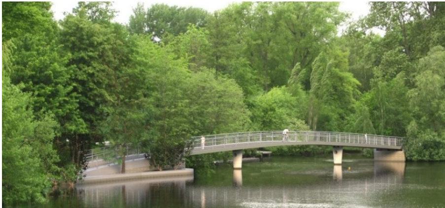
Abbildung 3 - Haynsparkbrücke (Quelle LSBG / Grassl Ing.)
