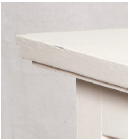
Profil schräg angefast und abgetreppt
