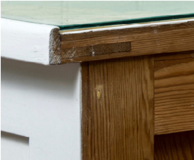
Der Anleimer fasste immer eine aufliegende Platte ein.
