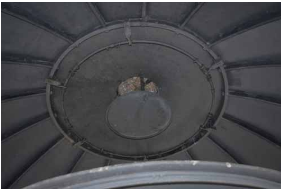
Tropffänger im Kuppelzenit unterhalb der Öffnung des Abzugs. Umlaufend die 2. Vorhangstange.
