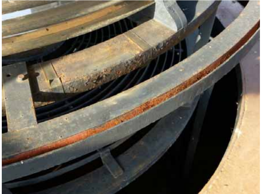
Halteschiene für Farbscheiben an der Einfassung der Optik (2019)
