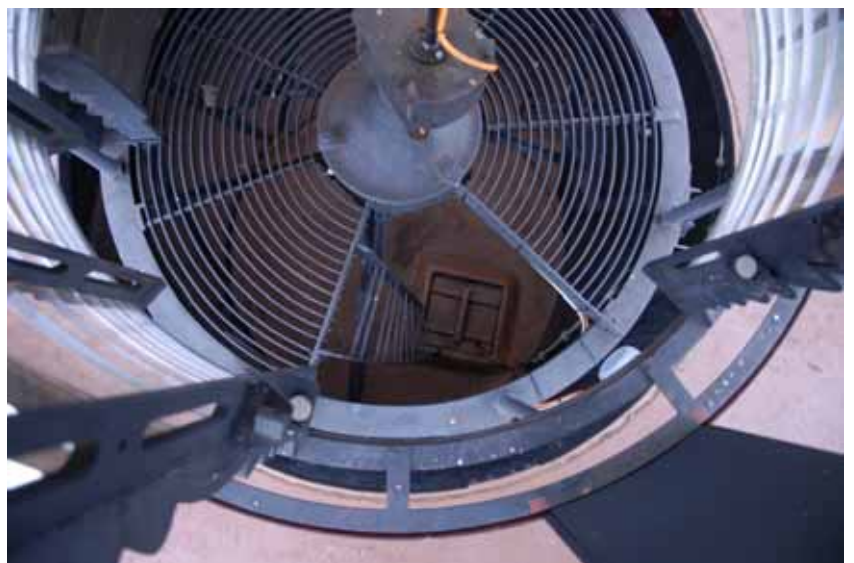
Blick von oben durch die Optik auf die Leiter zwischen Betriebs- und Optikebene
