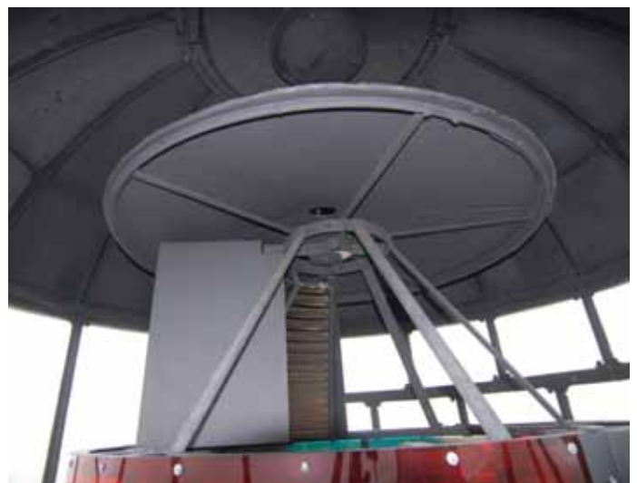
Abgedeckte obere Katadiopter der Optik
