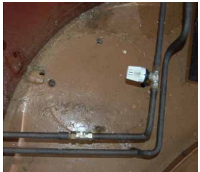
Unten: Sockelabdruck des Quecksilbermotors in der Betriebsebene des Leuchtturms Neuwerk
