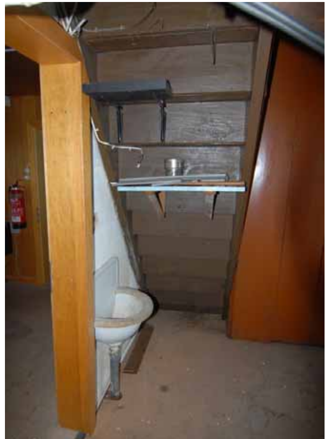
Waschbecken im Ruheraum; ganz rechts hinter dem Holzverschlag die Nische
