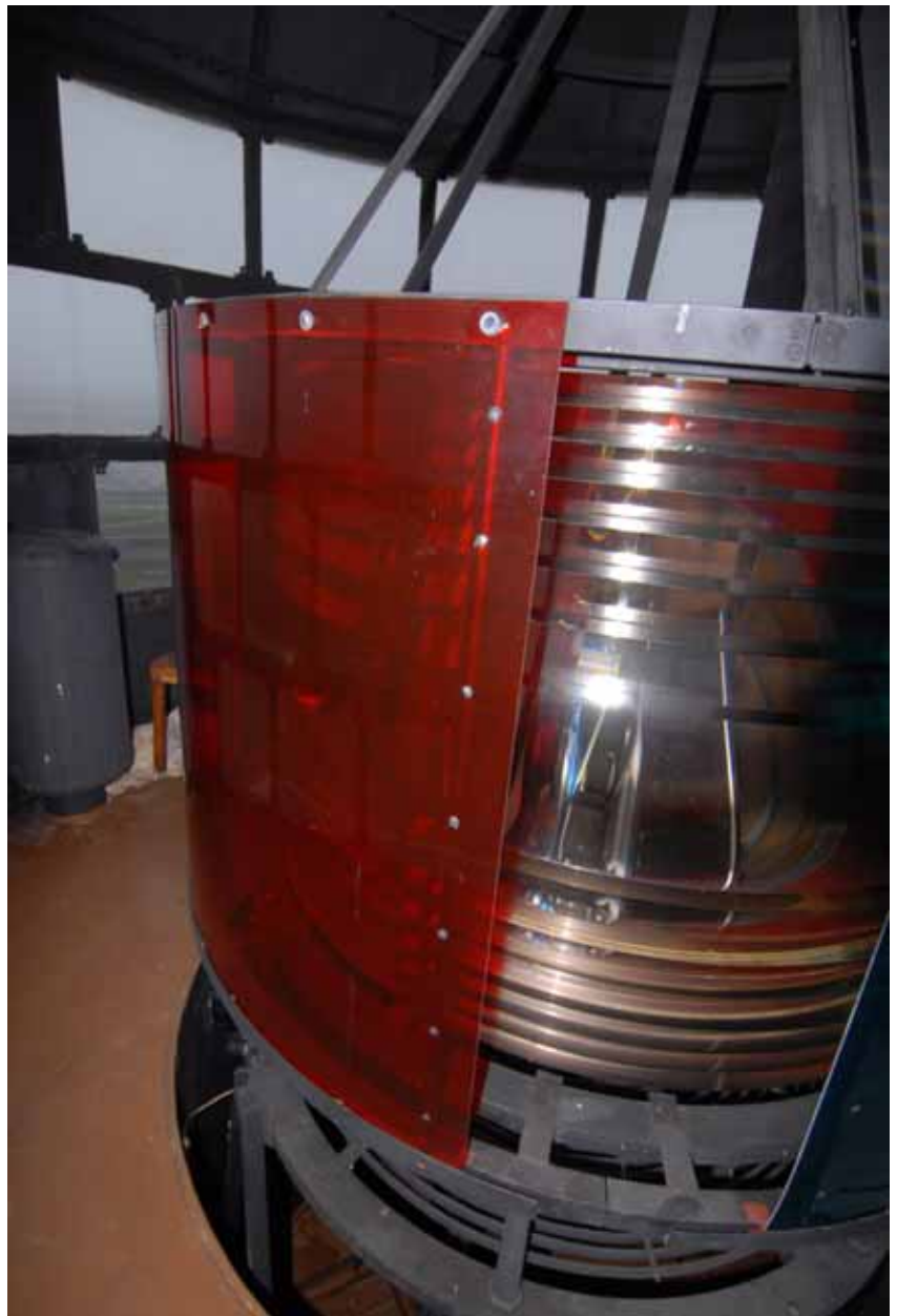
Optik mit in Halteschienen montierten Farbscheiben (2013)
