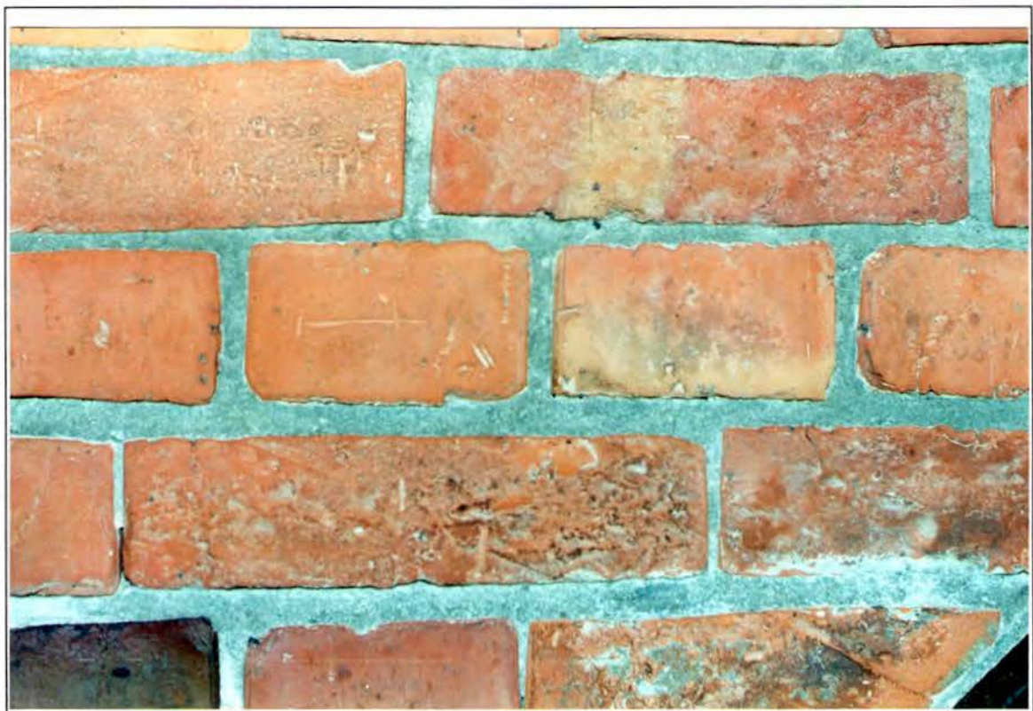
Bild 36: Mauerwerk im unteren Bereich der Nordfassade
