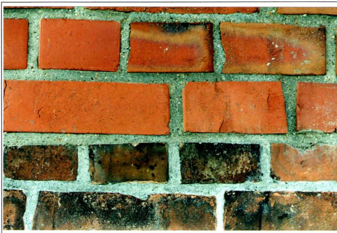
Bild 41: Übergang zwischen altem und neuem Mauerwerk auf der Ostfassade
