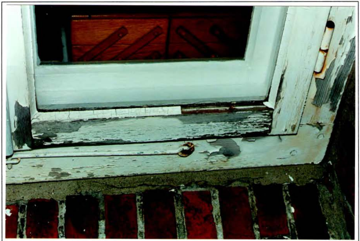
Bild 53: Schadhafter Fensterrahmen
