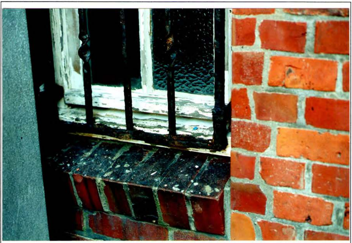
Bild 59: Korrodiertes Eisengitter
