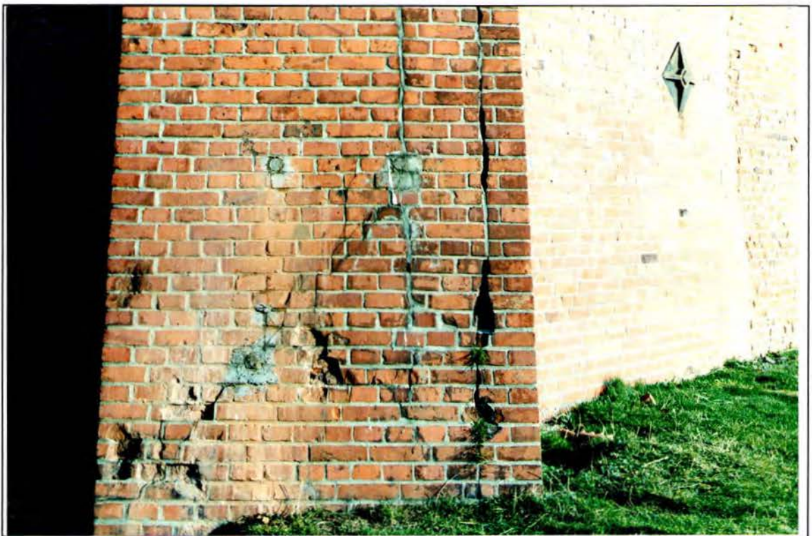
Bild 50a: Strebepfeiler an der südwestlichen Gebäudeecke
