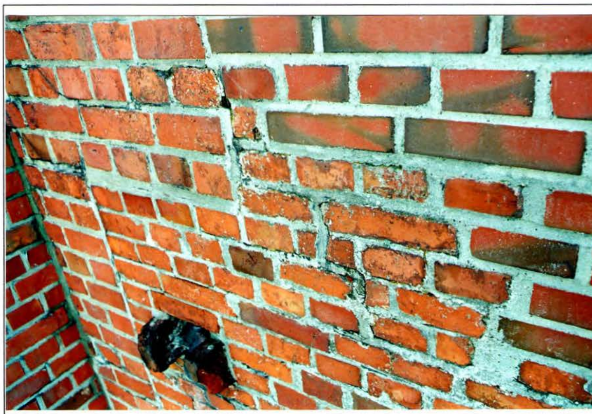
Bild 32: Übergang zwischen altem und neuem Mauerwerk, Nordfassade
