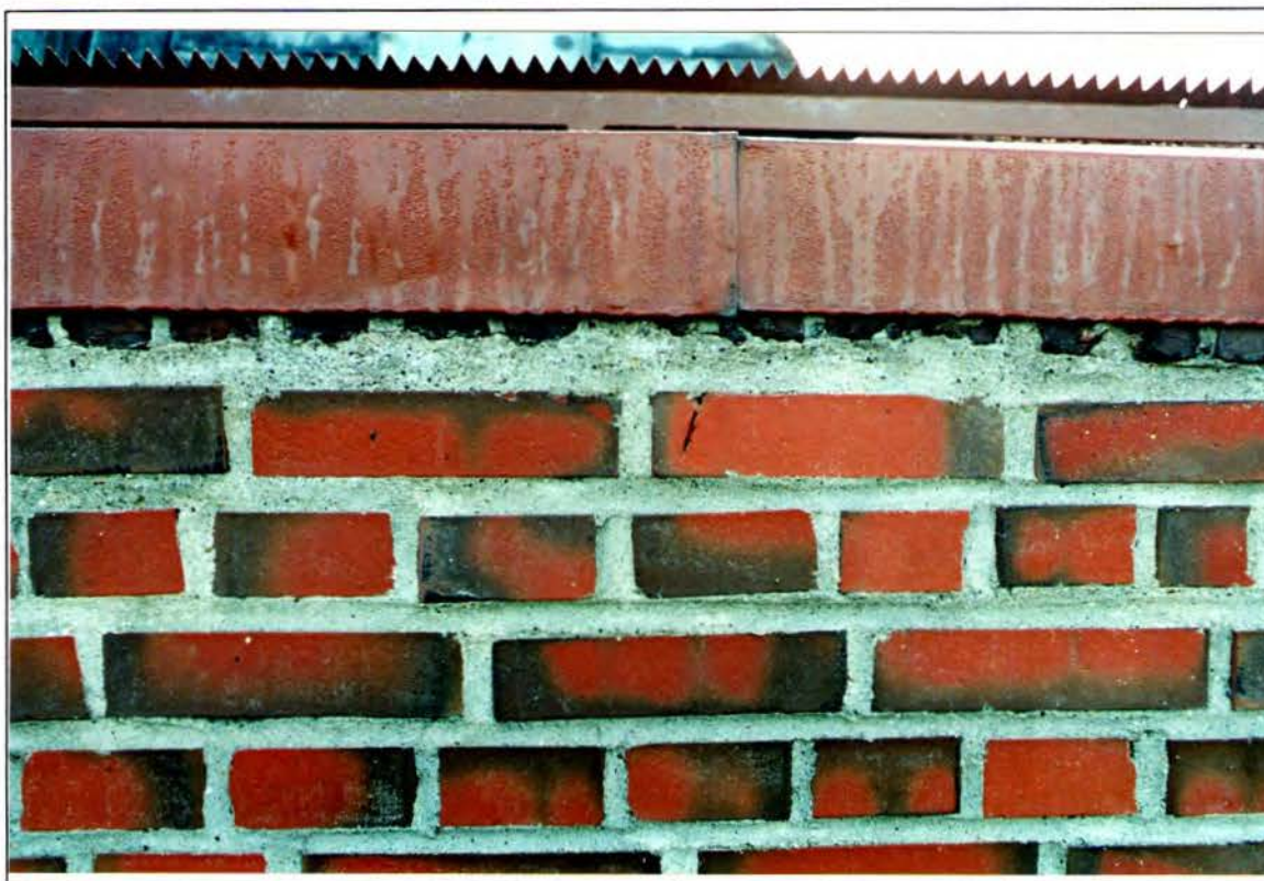
Bild 31: Neues Mauerwerk unterhalb der Attika, Nordfassade
