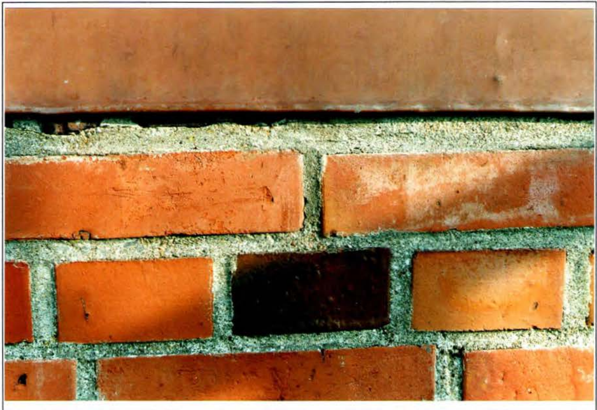
Bild 22: Neues Mauerwerk unterhalb der Attika der Westfassade
