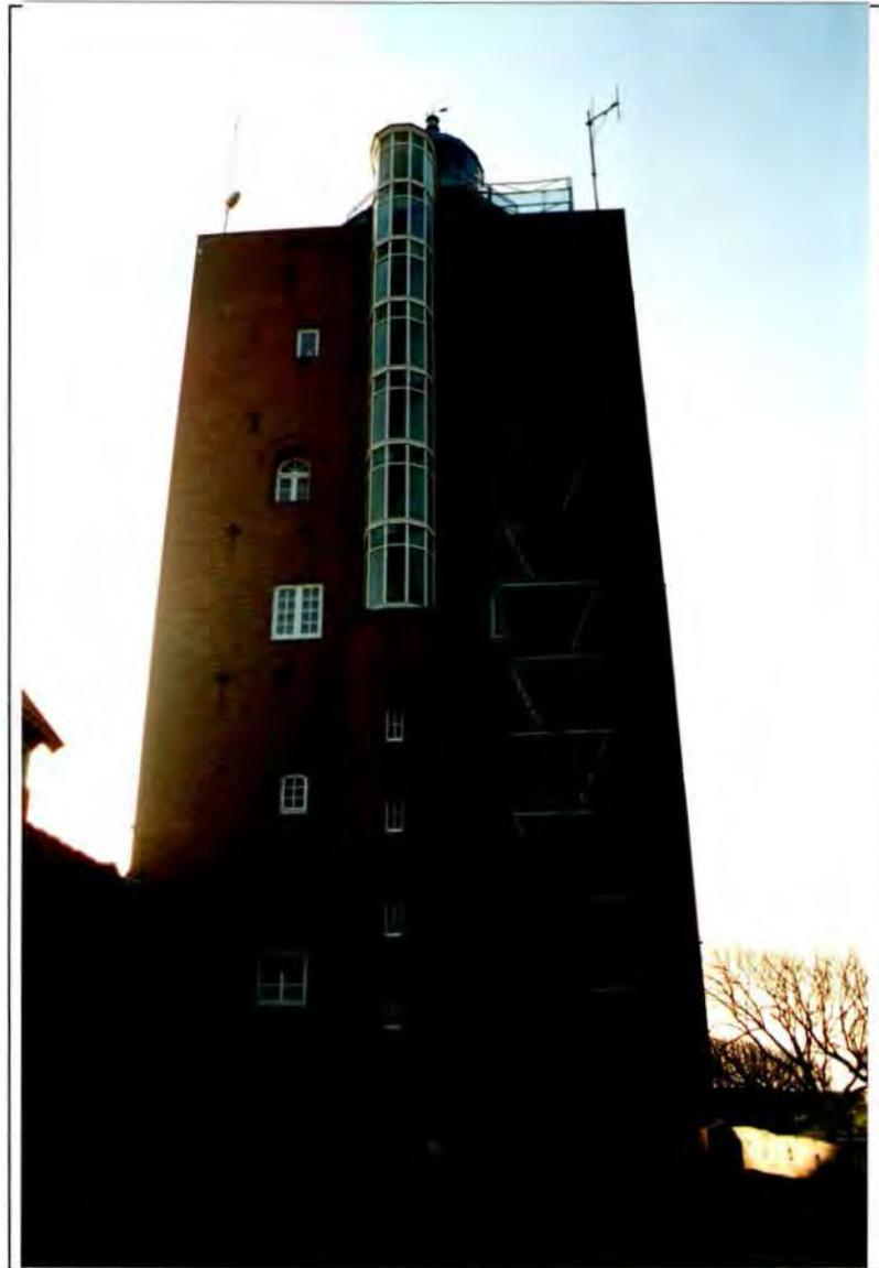
Bild 5: Nordfassade mit vorgebautem Treppenhaus
