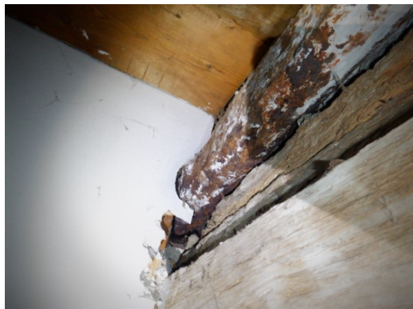
Bilder 7 und 8: Der Unterzug Nord-West ist mittels eines massiven Mauerankers im Mauerwerk eingebunden. Das Holz zeigt alte Braunfäuleschäden als Hinweis auf eine frühere Durchfeuchtung.
