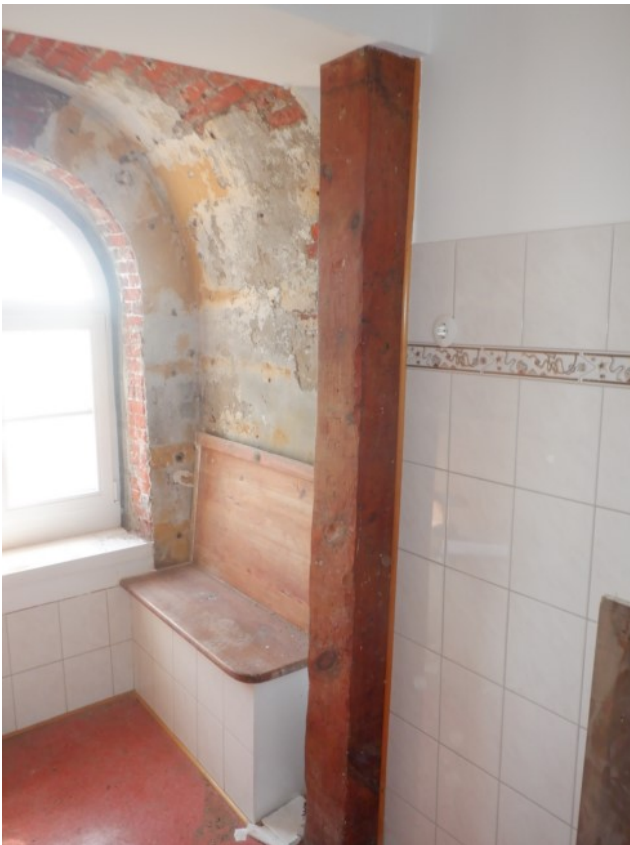
②: Bilder 26 und 27: Die Stütze ist im Wandaufbau völlig zerstört
