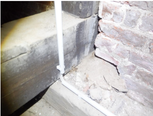
Bild 55: aufgestemmtes Auflager
