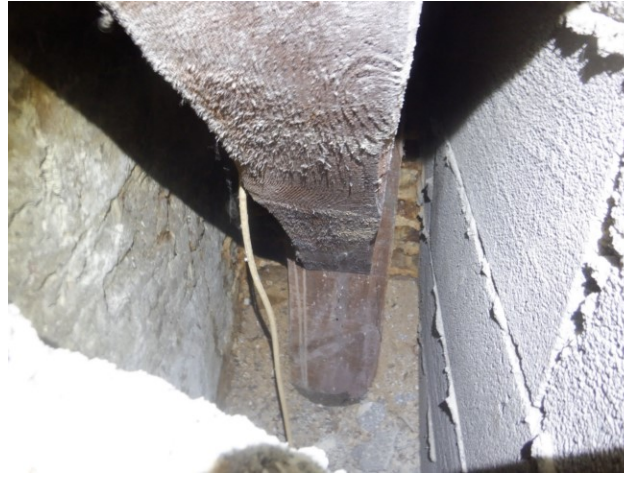
Bilder 59 und 60: Raum 5.4: Stiel ⑤ (offenbar Kiefer) ist in der Ecke verborgen. Keine Schäden. Stiel ④ steht auf einer Konsole. Keine Schäden
