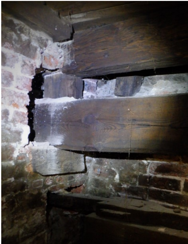
Bilder 36 und 37: Ostseite. Eine Schwelle liegt vor dem Mauerwerk. Die Balkenköpfe zeigen alte Braunfäuleschäden am Kopf (rechts), die die Tragfähigkeit nicht beeinträchtigen..
