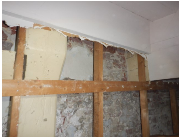
Bilder 15 und 16 (oben): Schwelle und Stiel am Treppenaufgang (Pos. ☉). Die Schwelle endet vor der Wandecke
