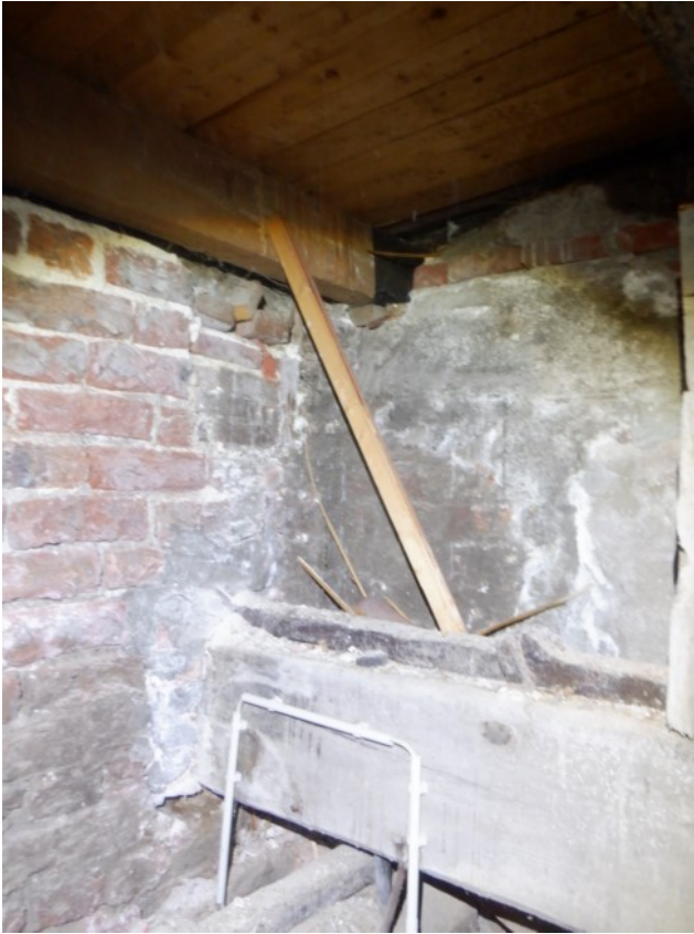
Bilder 53 und 54: Ein Balken war ausgewechselt worden. Er liegt offenbar nicht auf dem Mauerwerk auf (Hammer!)
