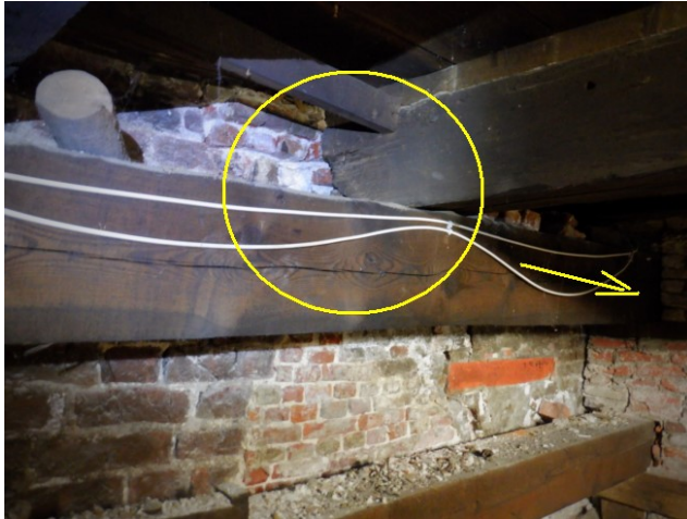
Bilder 36 und 37: Ostseite. Eine Schwelle liegt vor dem Mauerwerk. Die Balkenköpfe zeigen alte Braunfäuleschäden am Kopf (rechts), die die Tragfähigkeit nicht beeinträchtigen..
