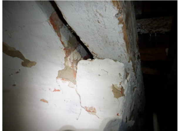
Bilder 13 und 14: Die Schwelle ist verrutscht, die Mauerwerks-Konsole zeigt Risse..
