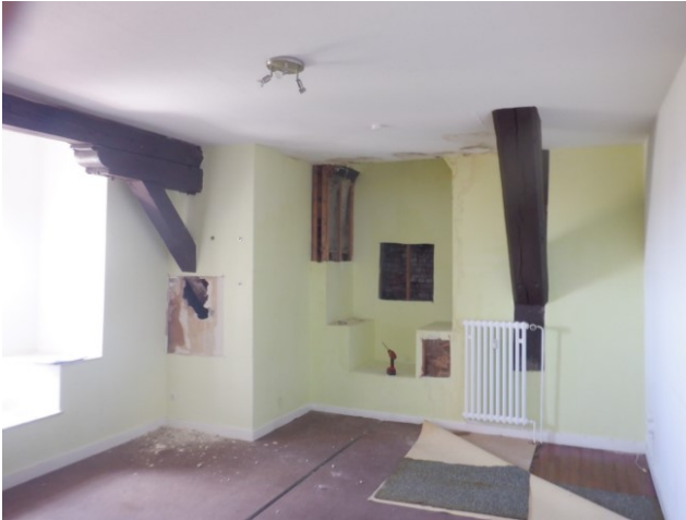
Bilder 59 und 60: Raum 5.4: Stiel ⑤ (offenbar Kiefer) ist in der Ecke verborgen. Keine Schäden. Stiel ④ steht auf einer Konsole. Keine Schäden
