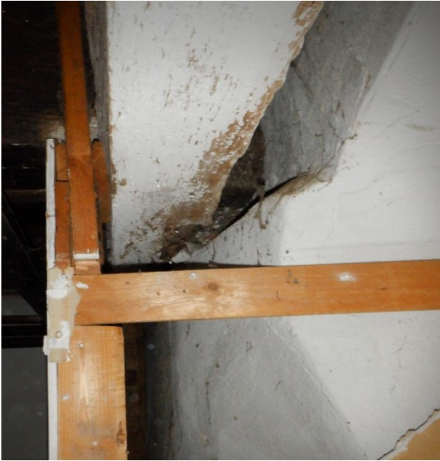
Bilder 13 und 14: Die Schwelle ist verrutscht, die Mauerwerks-Konsole zeigt Risse..
