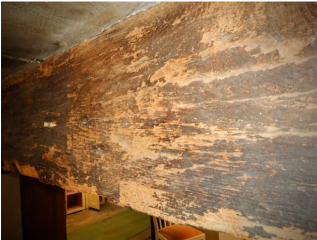
Bild 20: Alte Fraßschäden an der Oberfläche zeigen alte Feuchteschäden. Dieser Balken muß früher einmal über lange Zeit befeuchtet worden sein.
