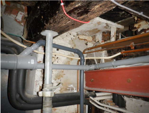
Bild 18: Kopf Süd-Ost: Anlaschung mittels Stahl
