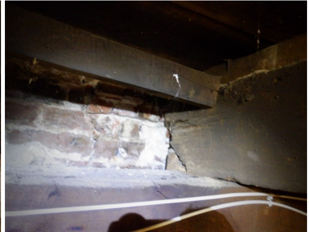
Bilder 36 und 37: Ostseite. Eine Schwelle liegt vor dem Mauerwerk. Die Balkenköpfe zeigen alte Braunfäuleschäden am Kopf (rechts), die die Tragfähigkeit nicht beeinträchtigen..
