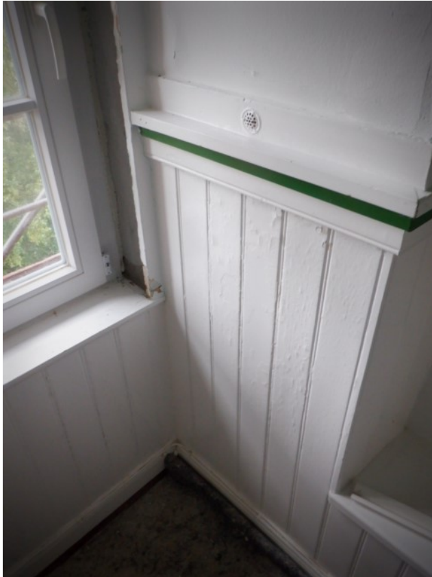
Bild 29 (links): Feuchteschäden an der Holzkonstruktion der Vorsatzschale.
