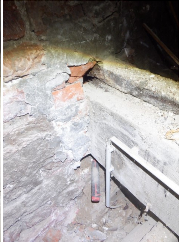
Bilder 53 und 54: Ein Balken war ausgewechselt worden. Er liegt offenbar nicht auf dem Mauerwerk auf (Hammer!)
