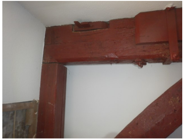
Bilder 61 und 62: Raum 5.3 Stiel ⑦ (Kiefer, links) steht auf einer Konsole. Stiel ③ (Eiche, rechts) steht frei
