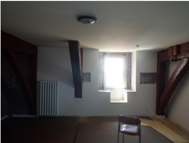
Bilder 61 und 62: Raum 5.3 Stiel ⑦ (Kiefer, links) steht auf einer Konsole. Stiel ③ (Eiche, rechts) steht frei
