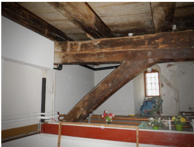
Bilder 9 und 10: Unterzug Nord-Ost. Die Bohrung zeigte, dass keine Holz mehr im Mauerwerk vorhanden war.
