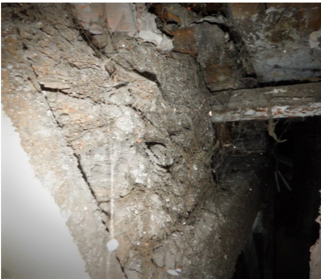
Bilder 15 und 16 (oben): Schwelle und Stiel am Treppenaufgang (Pos. ☉). Die Schwelle endet vor der Wandecke
