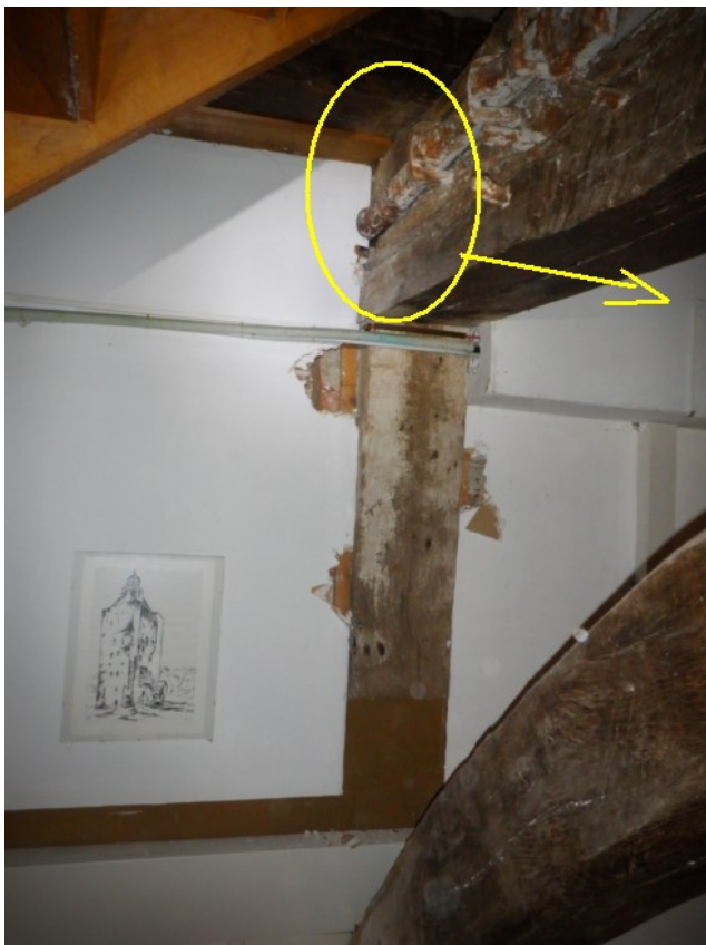
Bilder 7 und 8: Der Unterzug Nord-West ist mittels eines massiven Mauerankers im Mauerwerk eingebunden. Das Holz zeigt alte Braunfäuleschäden als Hinweis auf eine frühere Durchfeuchtung.
