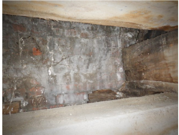
Bild 41: Pos. ⑤: Akuter Feuchteschaden und Fäulnis im Balkenkopf
