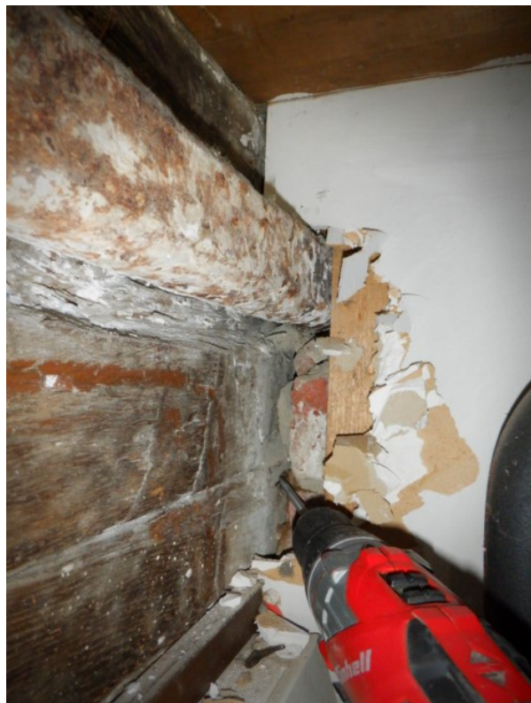
Bilder 9 und 10: Unterzug Nord-Ost. Die Bohrung zeigte, dass keine Holz mehr im Mauerwerk vorhanden war.
