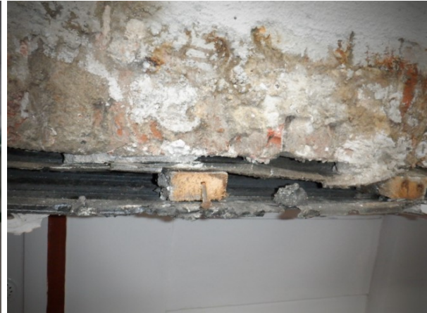
Bild 29 (links): Feuchteschäden an der Holzkonstruktion der Vorsatzschale.
