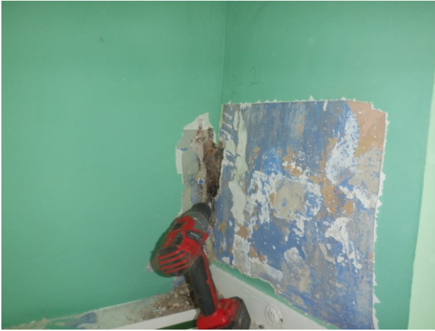
②: Bilder 26 und 27: Die Stütze ist im Wandaufbau völlig zerstört
