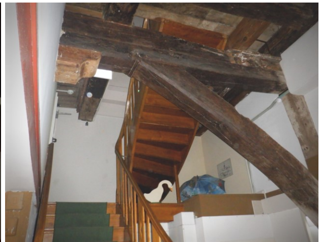
Bild 6: Unterzug am Treppenaufgang. Der Stiel ist weitgehend verkleidet.
