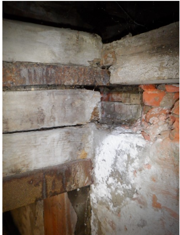
Bild 41: Pos. ⑤: Akuter Feuchteschaden und Fäulnis im Balkenkopf
