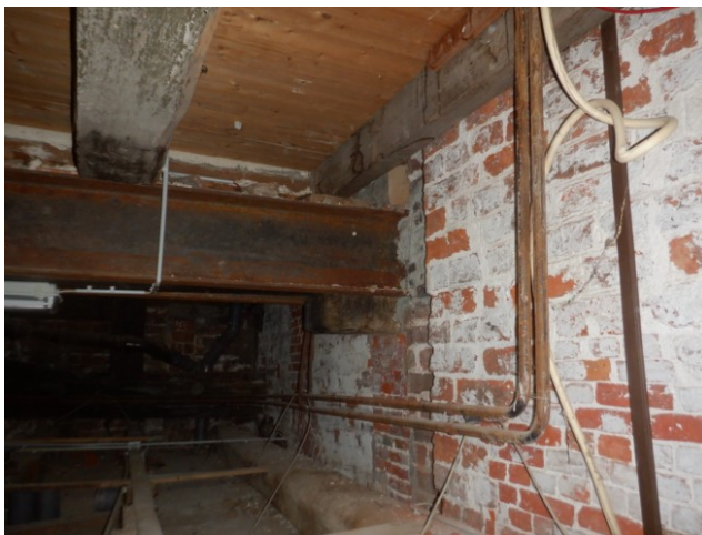
Bild 49 (oben): Stahlträger
