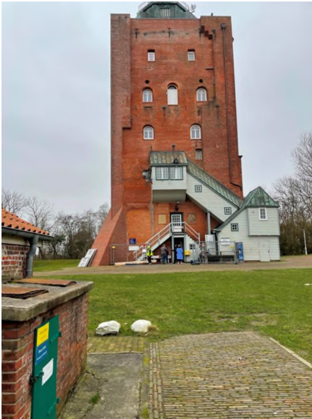
Abbildung 1: Leuchtturm Neuwerk mit außenliegendem Treppenaufgang
