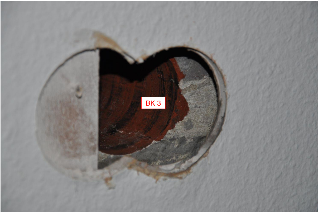
Abb. 22: Entnahmestelle des Bohrkerns BK 3 (Ebene 3, W-Seite)
