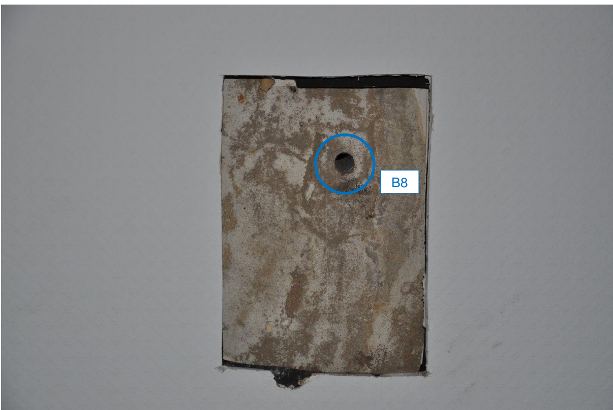
Abb. 49: Entnahmestelle der Bohrmehlprobe B8 (Ebene 5, N-Seite)
