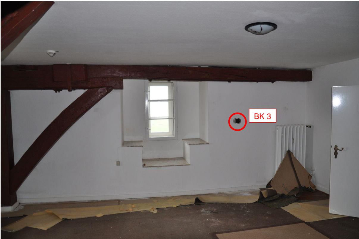
Abb. 20: Entnahmestelle des Bohrkerns BK 3 (Ebene 3, W-Seite)
