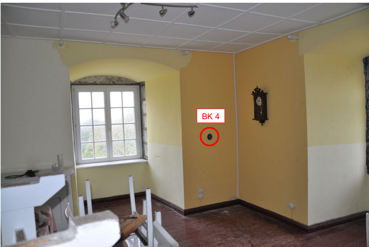
Abb. 23: Entnahmestelle des Bohrkerns BK 4 (Ebene 3, N-Seite)
