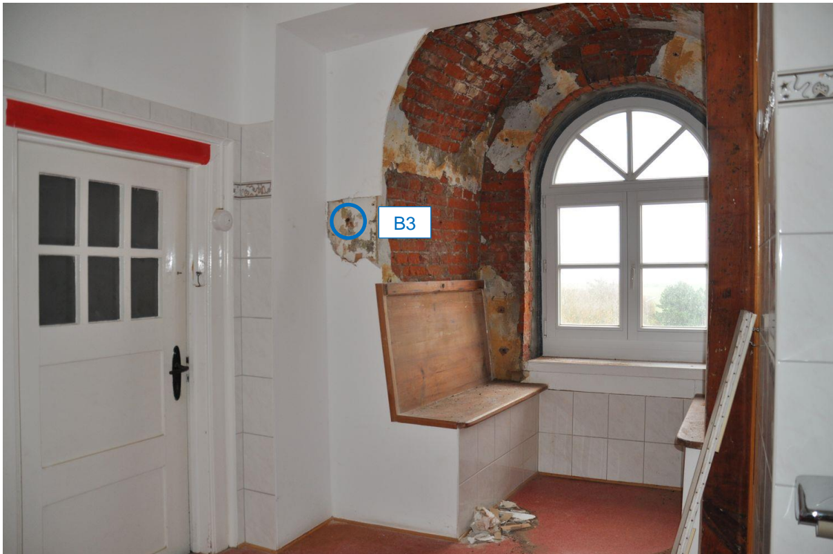
Abb. 34: Entnahmestelle der Bohrmehlprobe B3 (Ebene 3, O-Seite)
