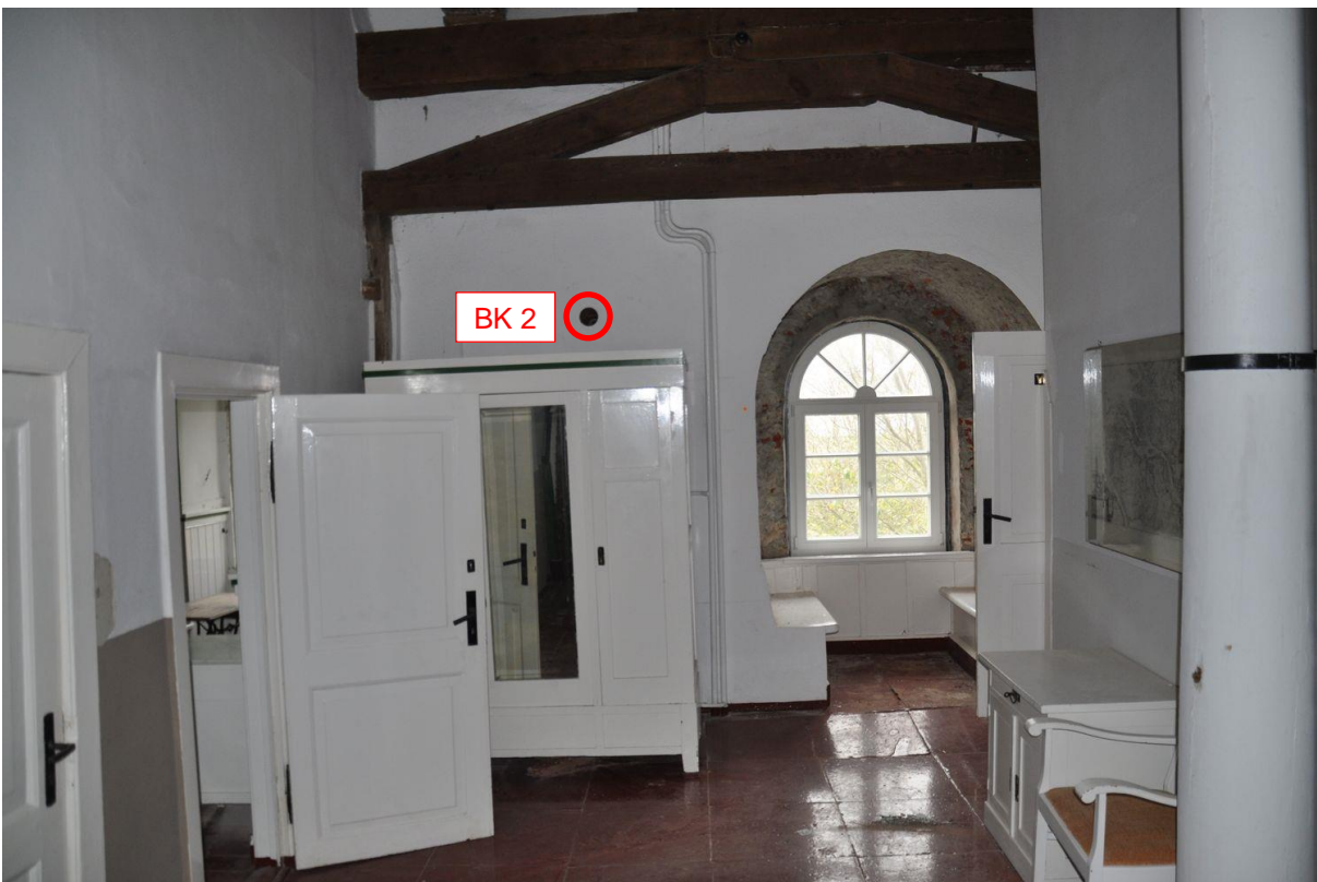
Abb. 17: Entnahmestelle des Bohrkerns BK 2 (Ebene 3, W-Seite)
