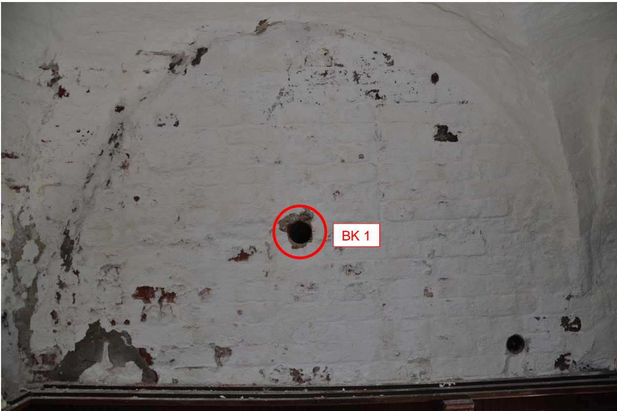
Abb. 16: Entnahmestelle des Bohrkerns BK 1 (Ebene 1, W-Seite)
