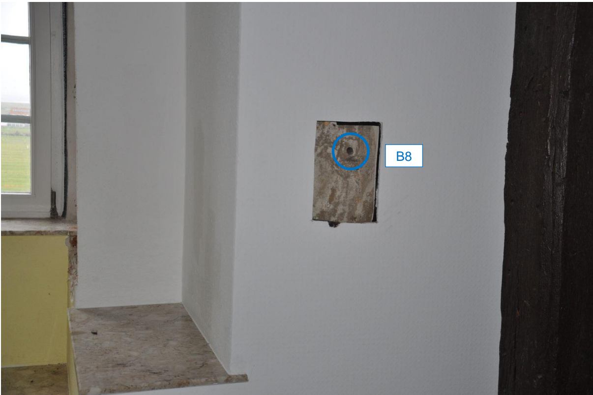
Abb. 48: Entnahmestelle der Bohrmehlprobe B8 (Ebene 5, N-Seite)
