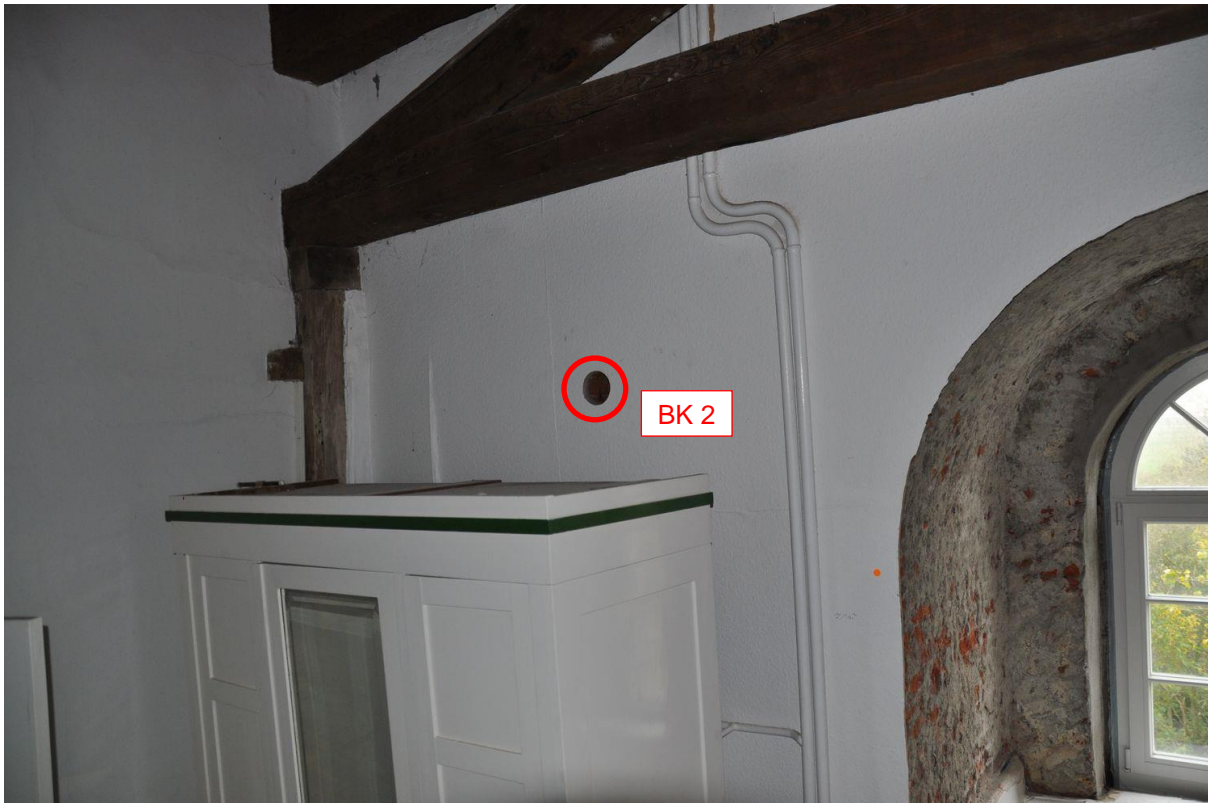
Abb. 18: Entnahmestelle des Bohrkerns BK 2 (Ebene 3, W-Seite)
