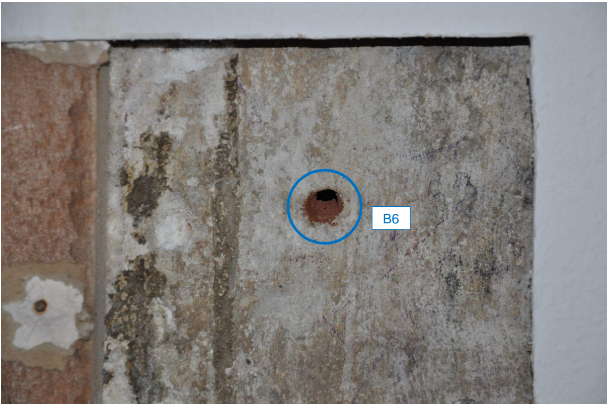
Abb. 44: Entnahmestelle der Bohrmehlprobe B6 (Ebene 5, S-Seite)
