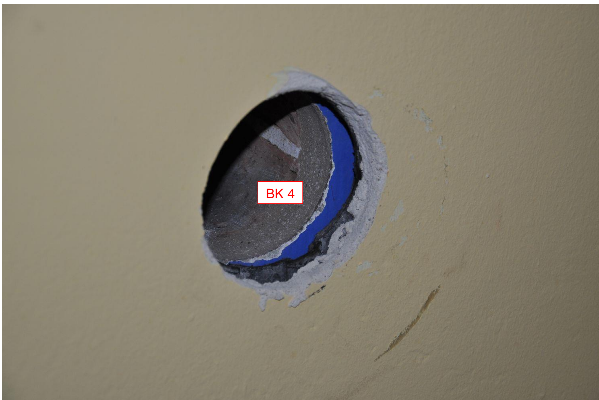
Abb. 25: Entnahmestelle des Bohrkerns BK 4 (Ebene 3, N-Seite)
