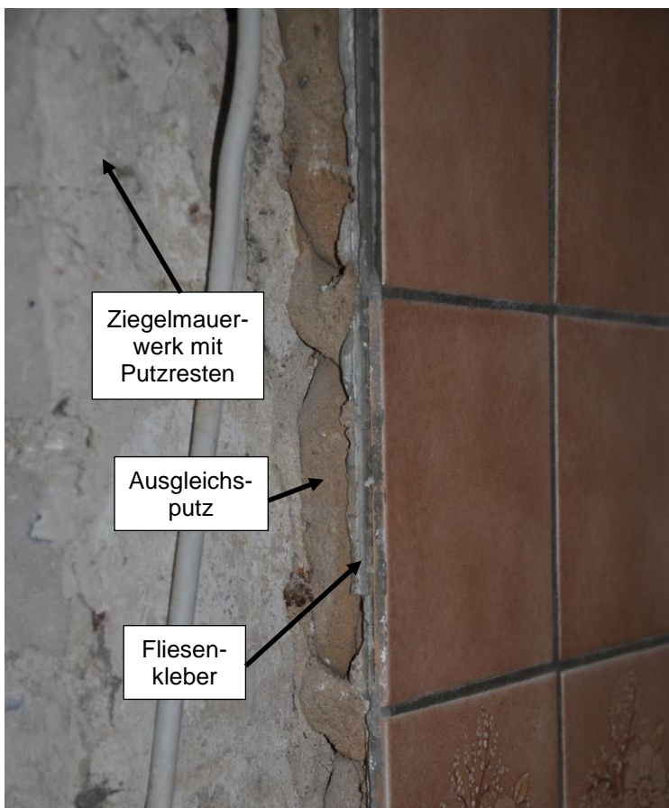
Abb. 32: Entnahmestelle der Bohrmehlprobe B2 (Ebene 1, N-Seite)
