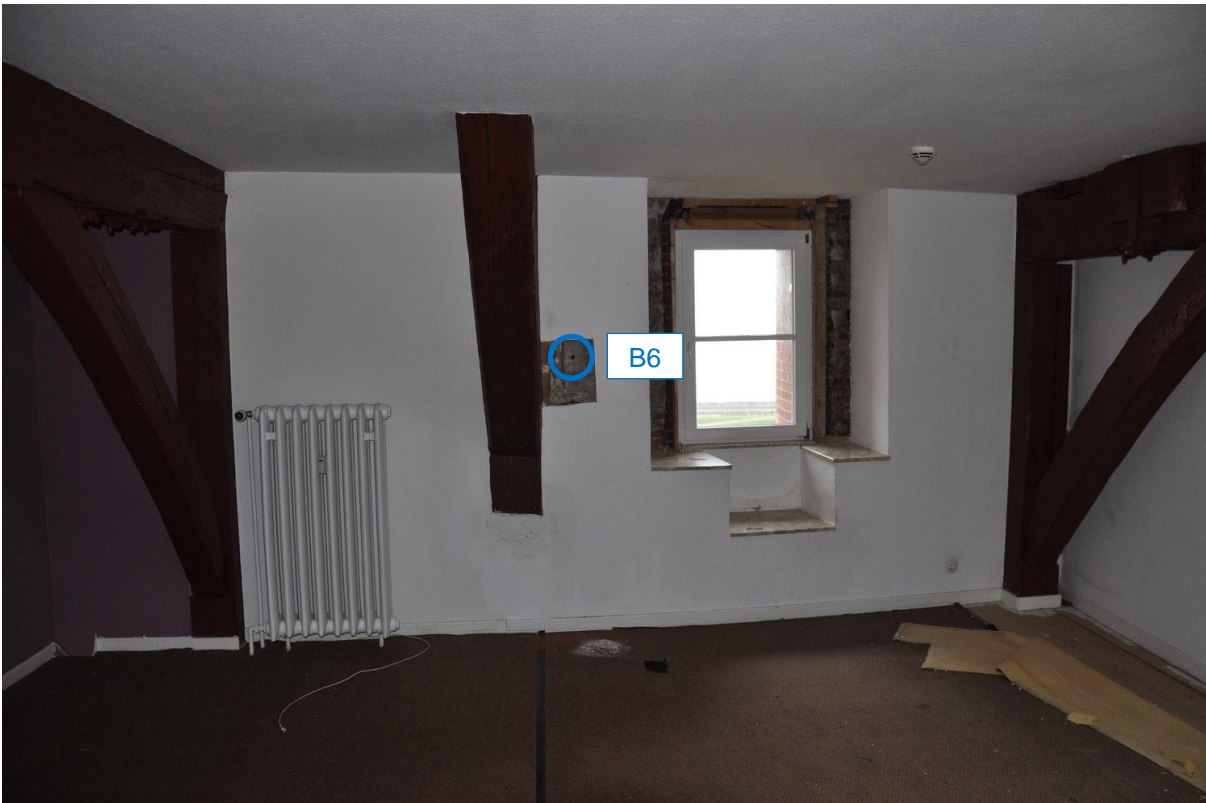
Abb. 42: Entnahmestelle der Bohrmehlprobe B6 (Ebene 5, S-Seite)
