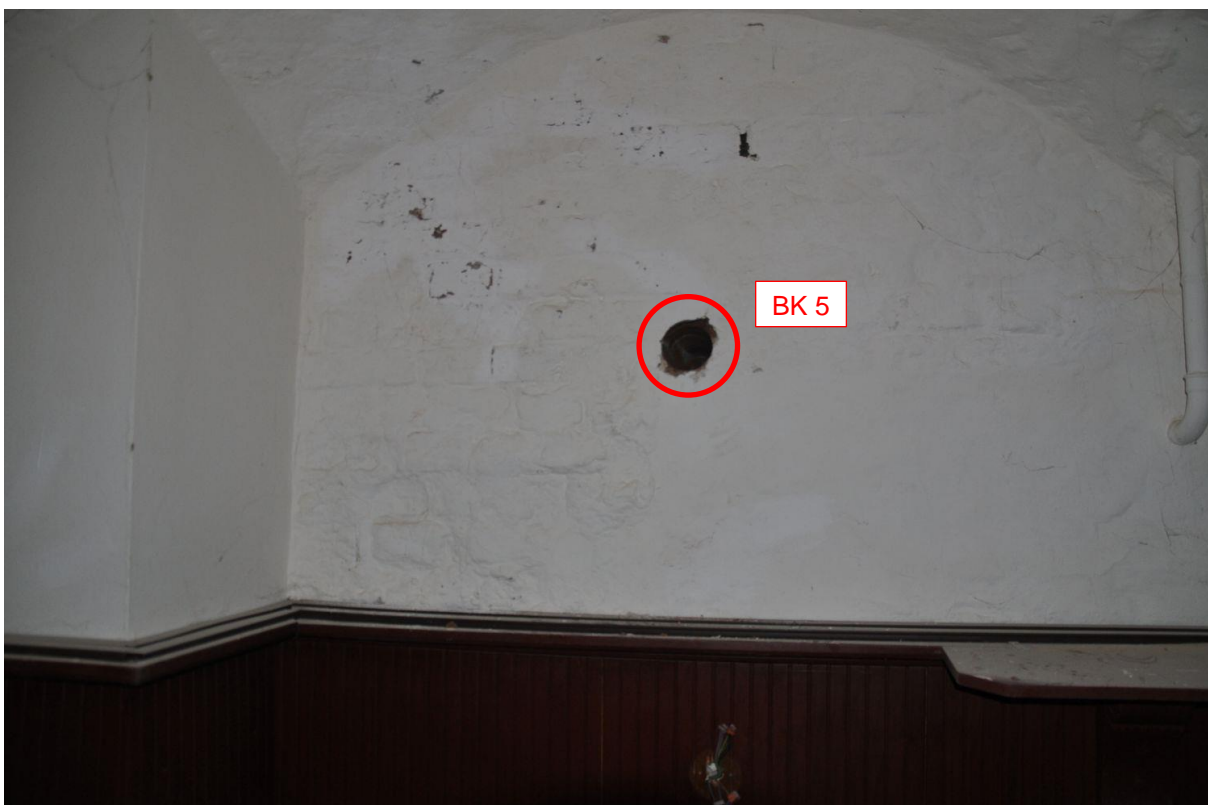
Abb. 27: Entnahmestelle des Bohrkerns BK 5 (Ebene 1, S-Seite)
