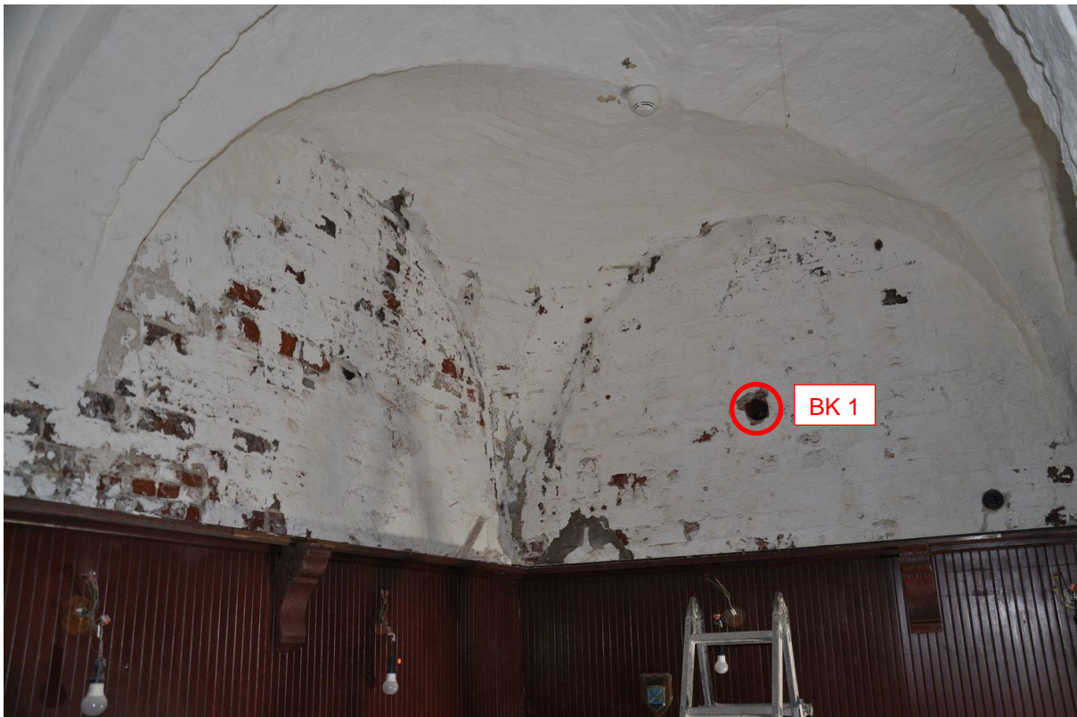
Abb. 15: Entnahmestelle des Bohrkerns BK 1 (Ebene 1, W-Seite)
