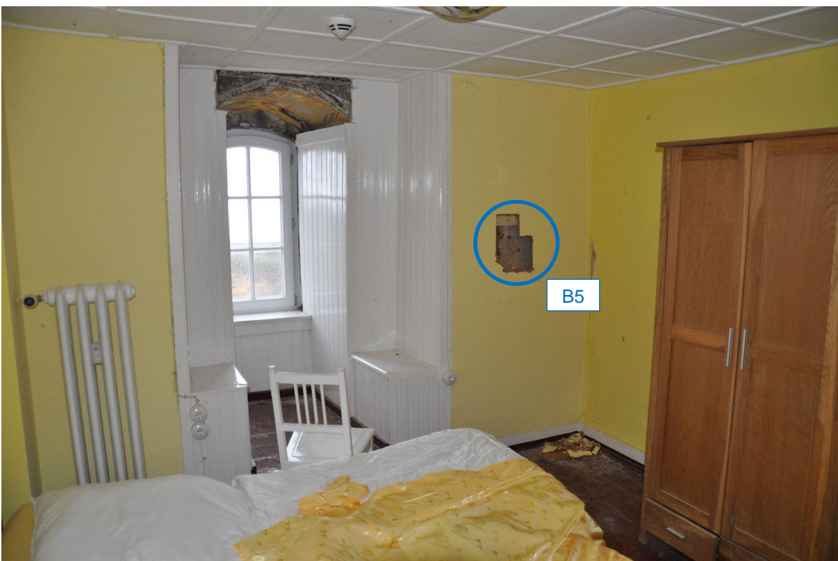
Abb. 39: Entnahmestelle der Bohrmehlprobe B5 (Ebene 3, S-Seite)
