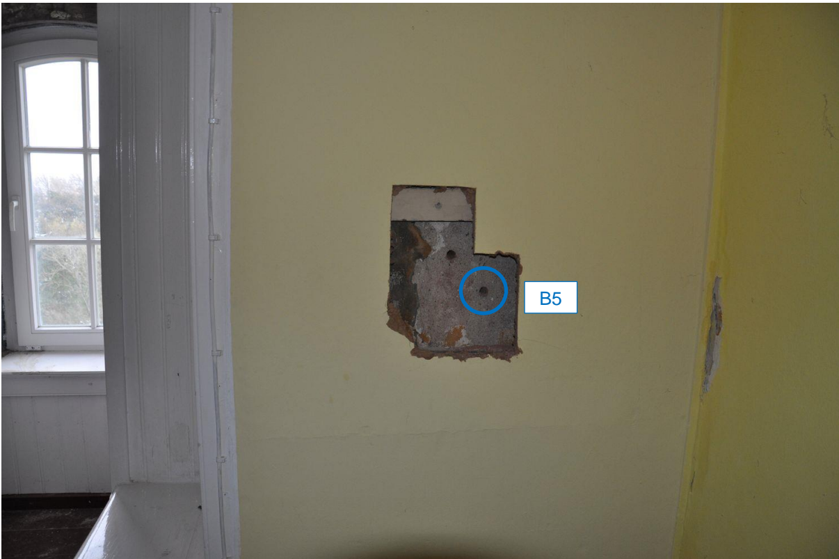
Abb. 40: Entnahmestelle der Bohrmehlprobe B5 (Ebene 3, S-Seite)
