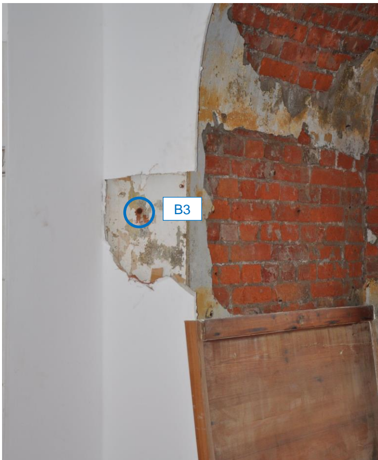
Abb. 34: Entnahmestelle der Bohrmehlprobe B3 (Ebene 3, O-Seite)
