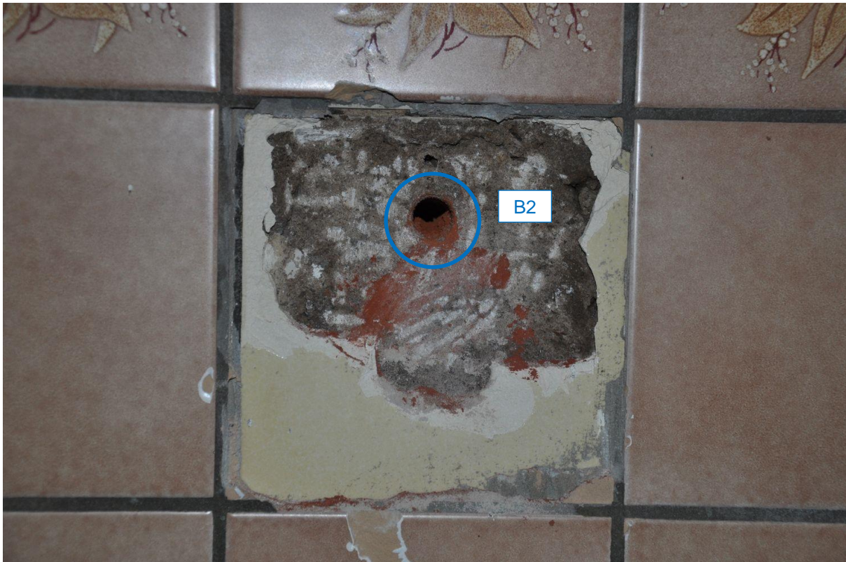
Abb. 32: Entnahmestelle der Bohrmehlprobe B2 (Ebene 1, N-Seite)
