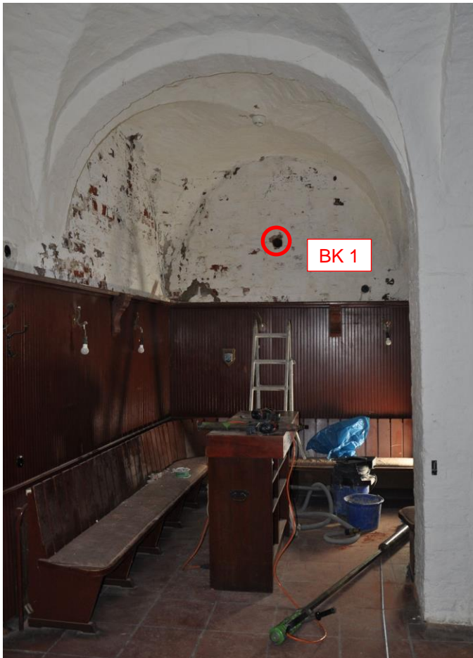
Abb. 14: Entnahmestelle des Bohrkerns BK 1 (Ebene 1, W-Seite)
