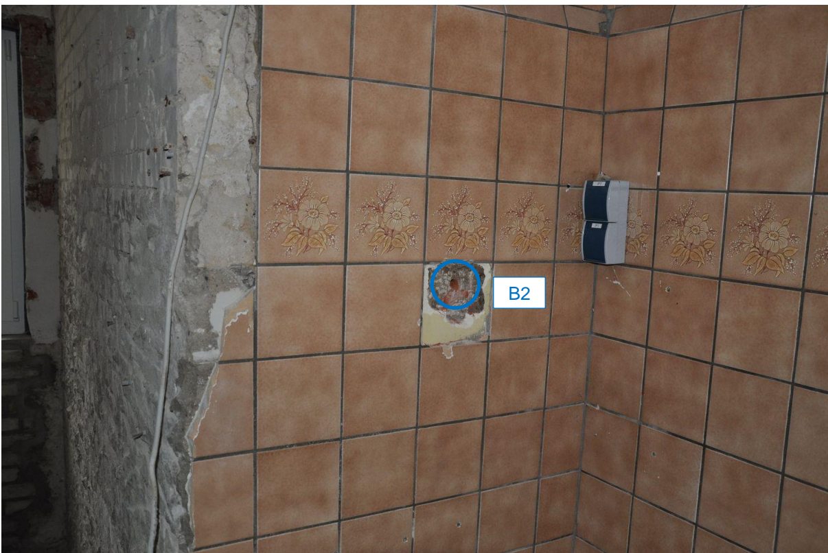
Abb. 31: Entnahmestelle der Bohrmehlprobe B2 (Ebene 1, N-Seite)
