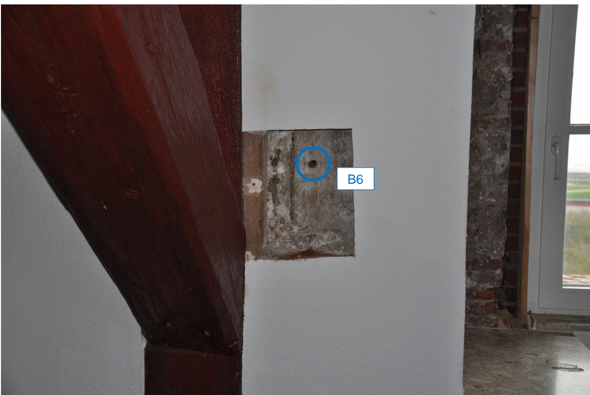
Abb. 43: Entnahmestelle der Bohrmehlprobe B6 (Ebene 5, S-Seite)
