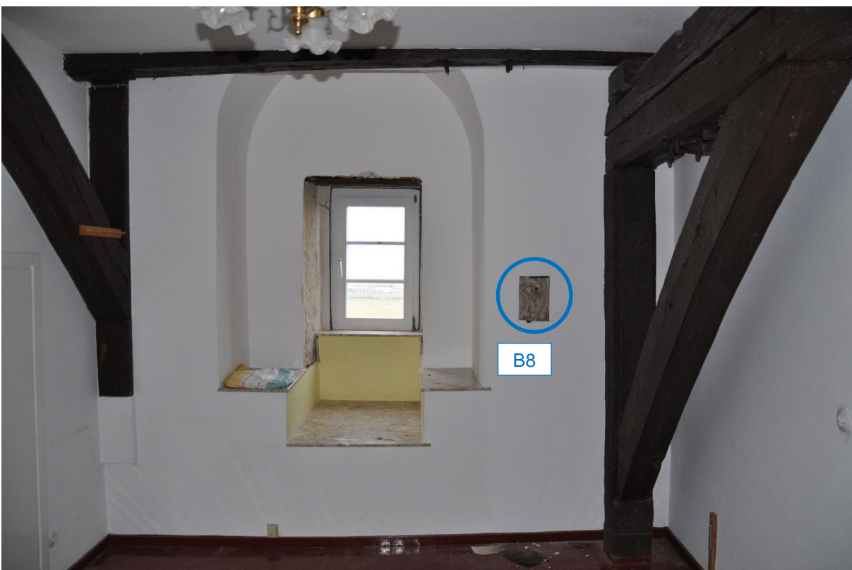
Abb. 47: Entnahmestelle der Bohrmehlprobe B8 (Ebene 5, N-Seite)
