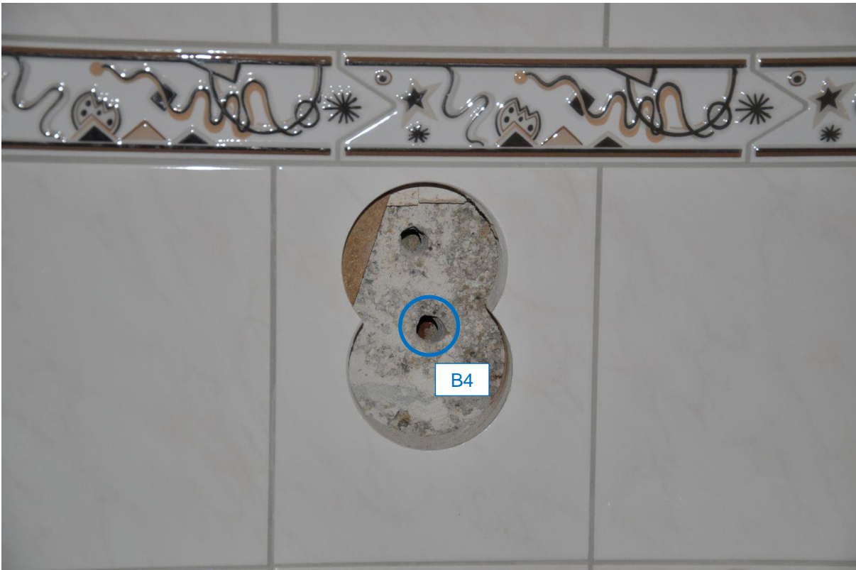
Abb. 38: Entnahmestelle der Bohrmehlprobe B4 (Ebene 3, S-Seite)
