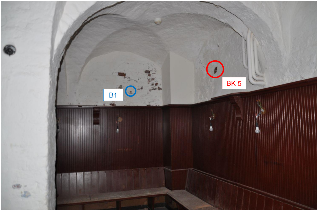
Abb. 26: Entnahmestelle des Bohrkerns BK 5 (Ebene 1, S-Seite) und der Bohrmehlprobe B1 (Ebene 1, O-Seite)
