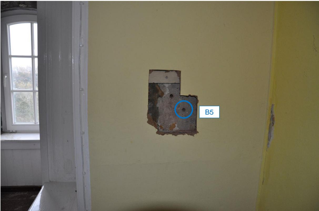
**Abb. 40:** Entnahmestelle der Bohrmehlprobe **B5** (Ebene 3, S-Seite)
