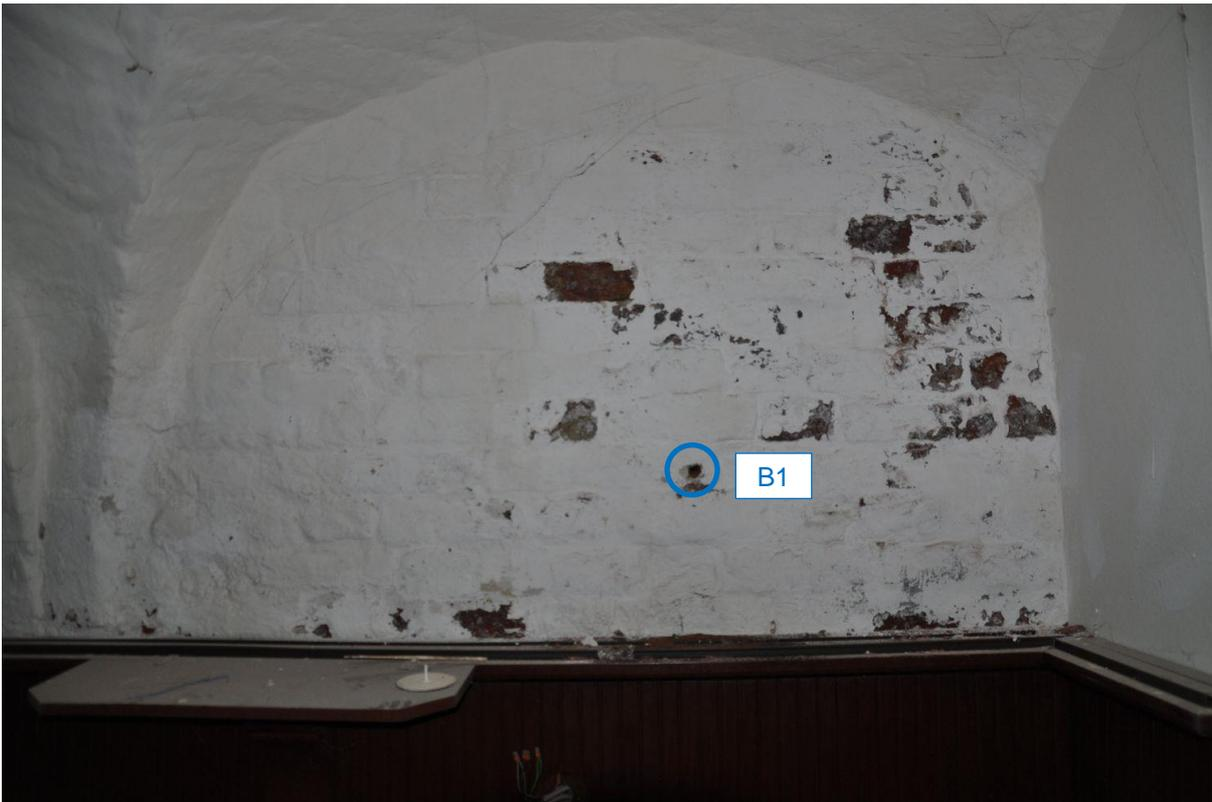
**Abb. 28:** Entnahmestelle der Bohrmehlprobe **B1** (Ebene 1, O-Seite)
