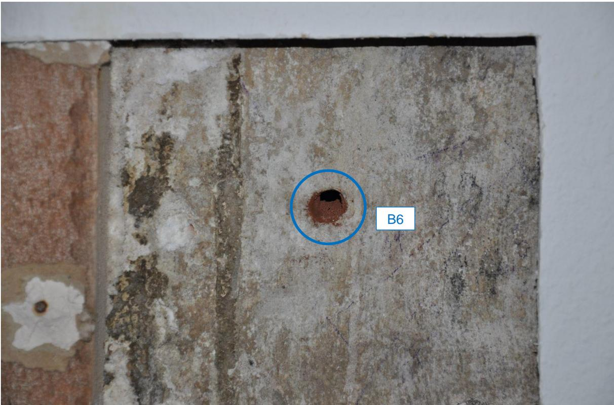
**Abb. 44:** Entnahmestelle der Bohrmehlprobe **B6** (Ebene 5, S-Seite)
