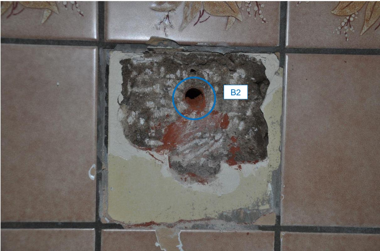
**Abb. 32:** Entnahmestelle der Bohrmehlprobe **B2** (Ebene 1, N-Seite)
