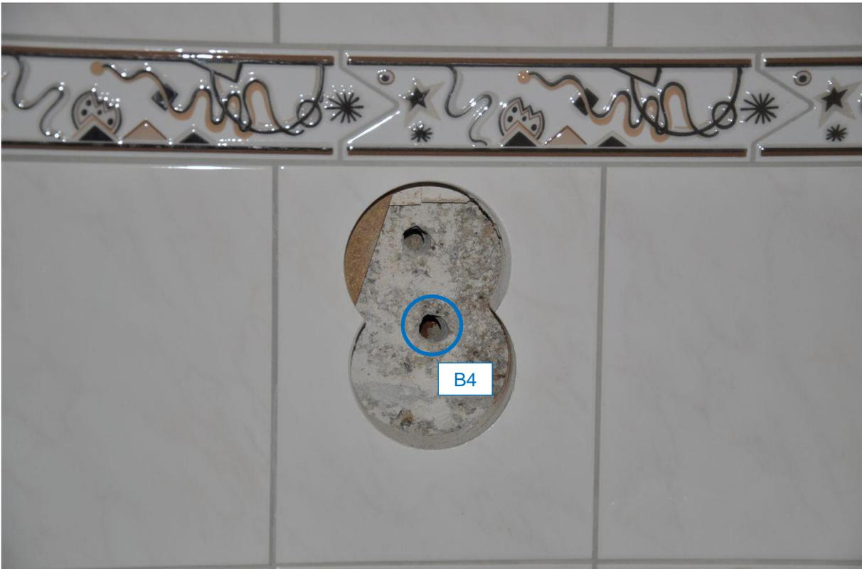
**Abb. 38:** Entnahmestelle der Bohrmehlprobe **B4** (Ebene 3, S-Seite)
