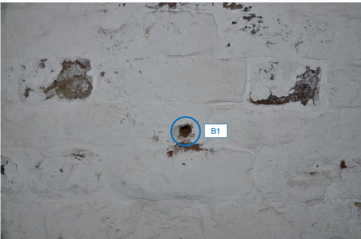
**Abb. 29:** Entnahmestelle der Bohrmehlprobe **B1** (Ebene 1, O-Seite)
