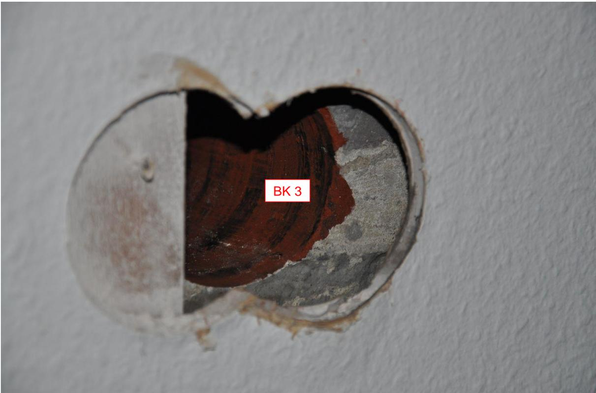
**Abb. 22:** Entnahmestelle des Bohrkerns **BK 3** (Ebene 3, W-Seite)
