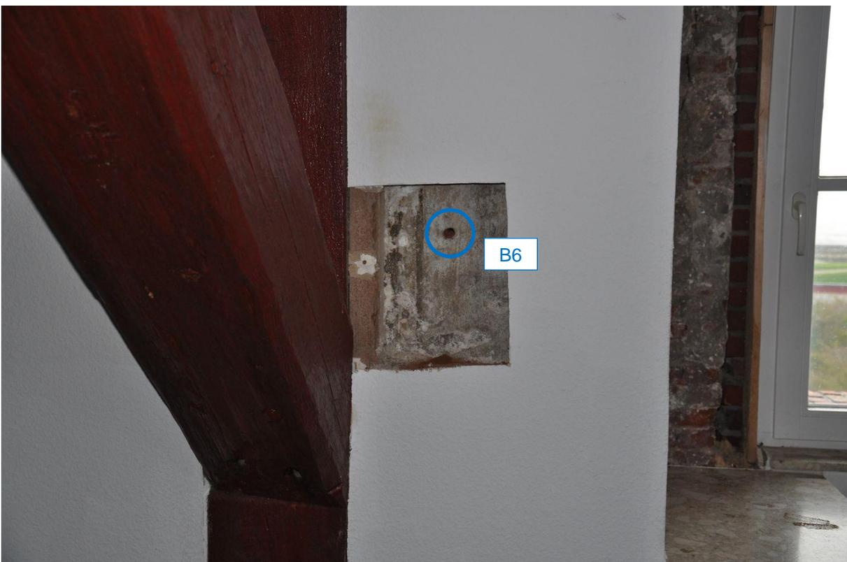
**Abb. 43:** Entnahmestelle der Bohrmehlprobe **B6** (Ebene 5, S-Seite)
