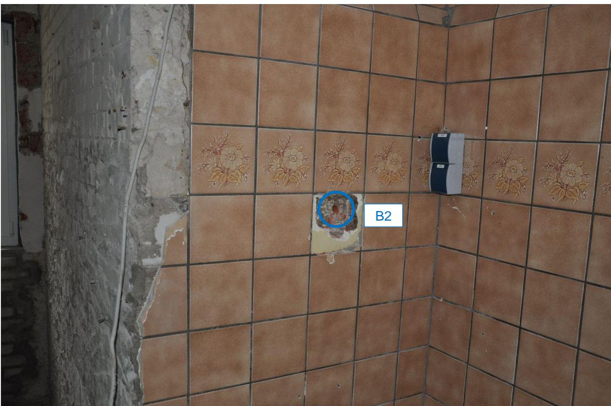
Abb. 31: Entnahmestelle der Bohrmehlprobe **B2** (Ebene 1, N-Seite)
